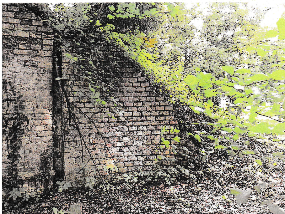
6. Rakoniewice . Lodownia . Bruzda na styku ściany portalowej ze ścianą esownicową (strona prawa)
