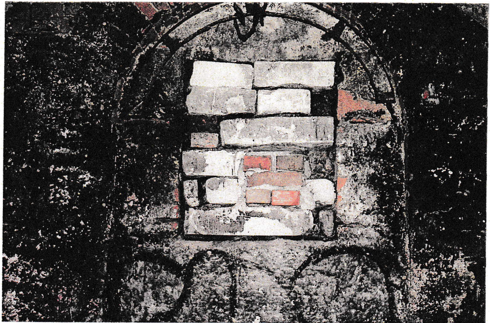
13. Rakoniewice . Lodownia . Przemurowany otwór wejścia głównego .
