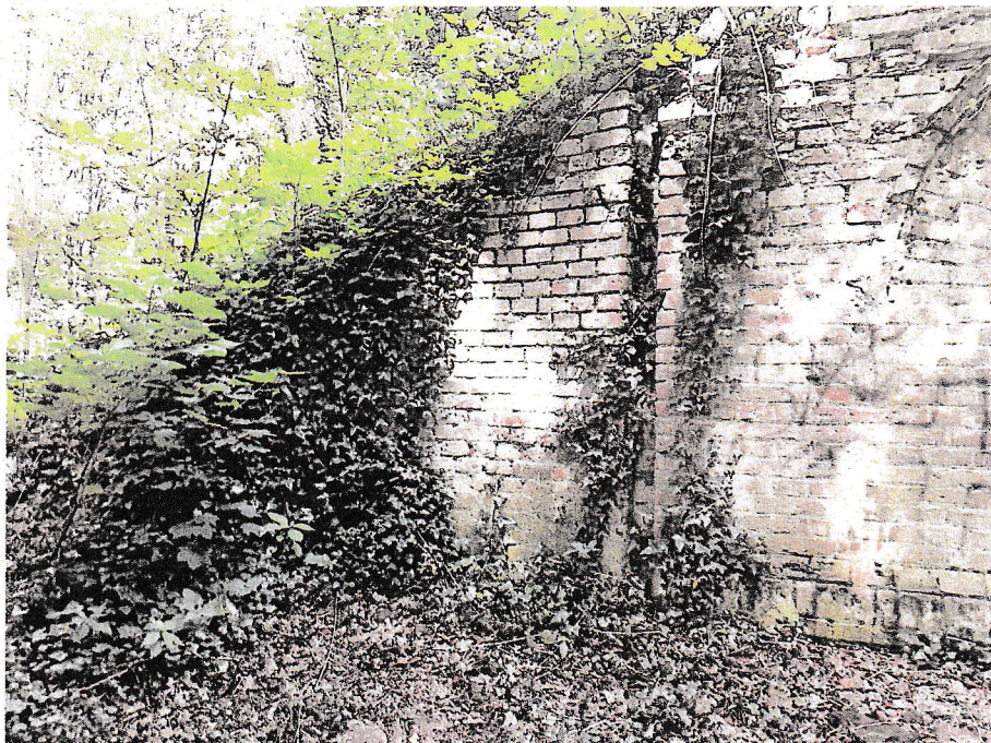
5. Rakoniewice . Lodownia . Bruzda na styku ściany portalowej ze ścianą esownicową (strona lewa )
